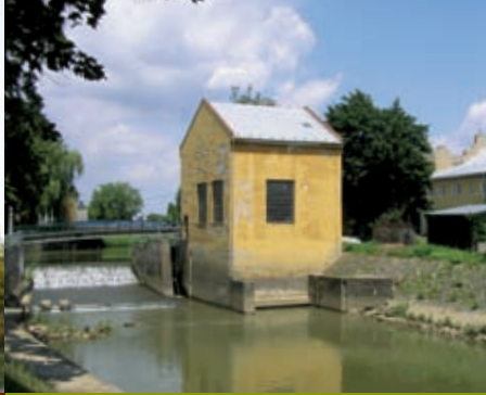
Vodná elektrárňa, Veselí n. Mor.
